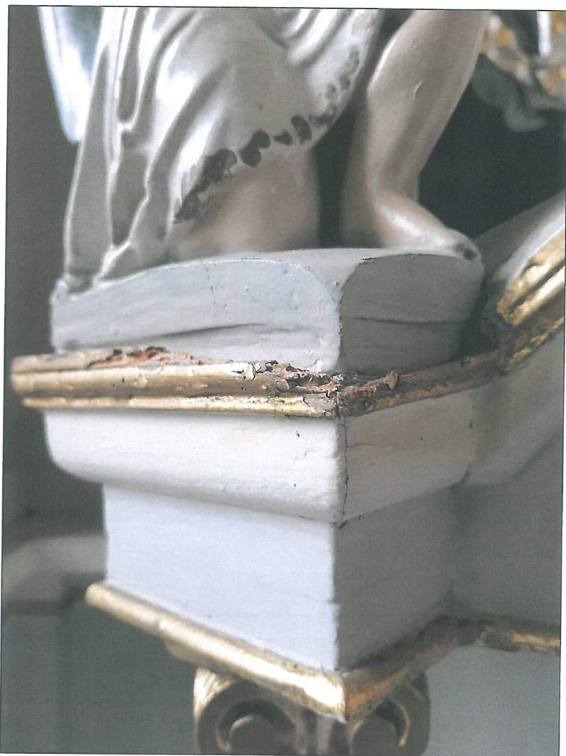
Fot.13. kościół parafialny p.w. św. Doroty w Grochowych. Ołtarz boczny (w skrzydle lewym transeptu) p.w. Św. Alojzego Gonzagi. Lewy górny fragment nadstawki: widoczny stan zachowania drewna wynikający z działania drewnojadów. Stan z 15.02.2018 r.
