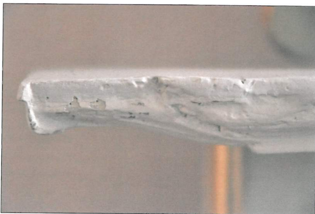
Fot.23. kościół parafialny p.w. św. Doroty w Grochowych. Ołtarz boczny (w skrzydle prawym transeptu) p.w. Św. Tekli. Detal: fragment wolutowej konsoli z lewej strony ołtarza – widoczny stan zachowania drewna. Stan z 15.02.2018 r.
